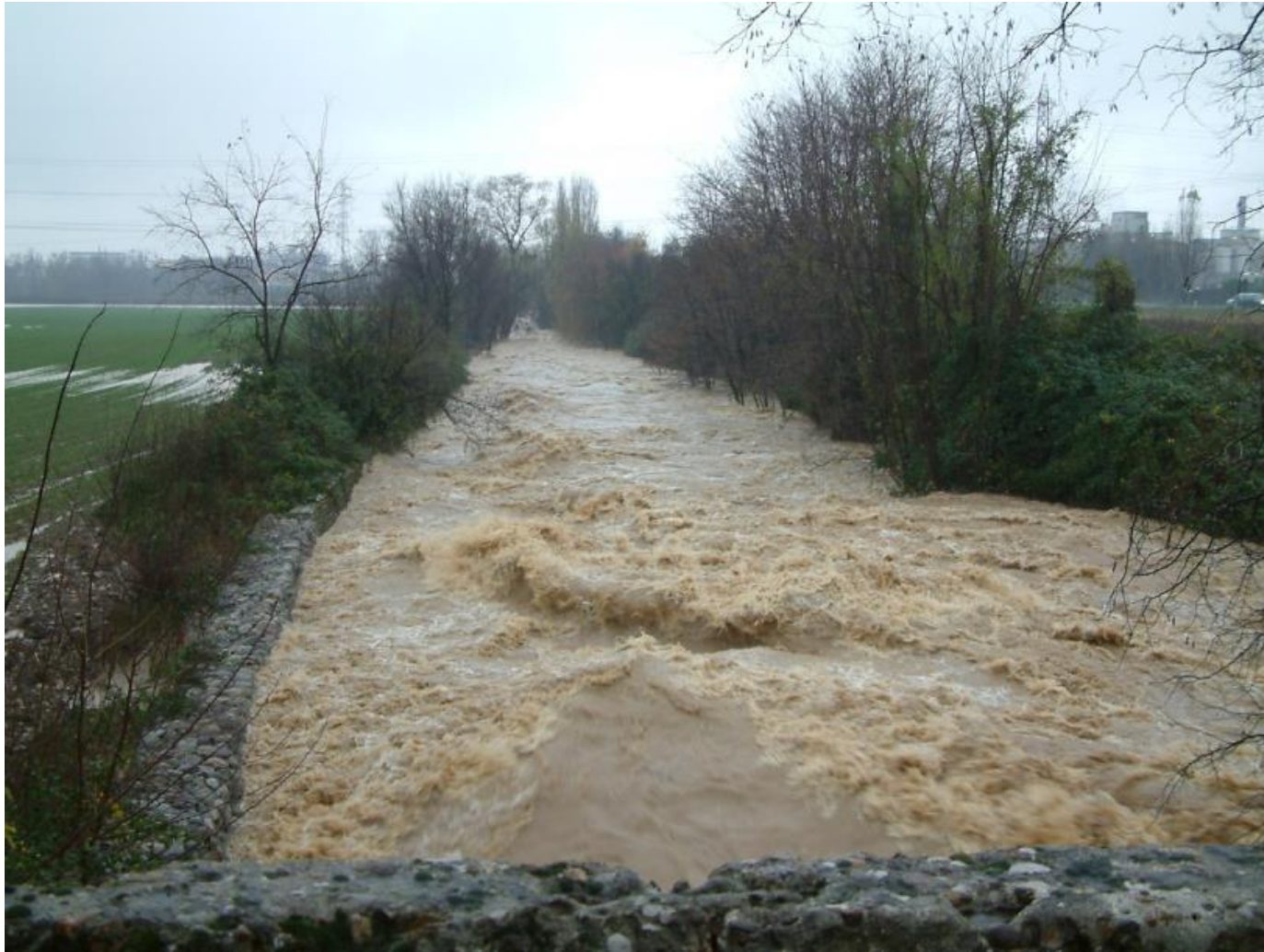
Ponte di via Trento in direzione S
